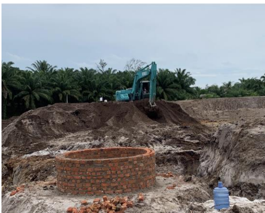
Konstruksi Saluran Pembuangan
