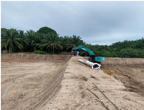
Pembentukan Cut & Fill tanggul Kolam Budidaya
