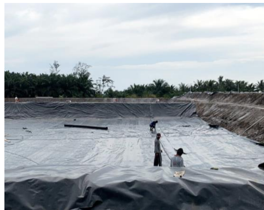
Pemasangan pelapis HDPE pada kolam budidaya
