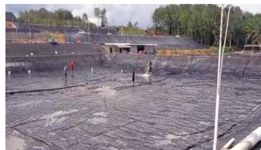
Pembersihan Kolam & Perbaikan
