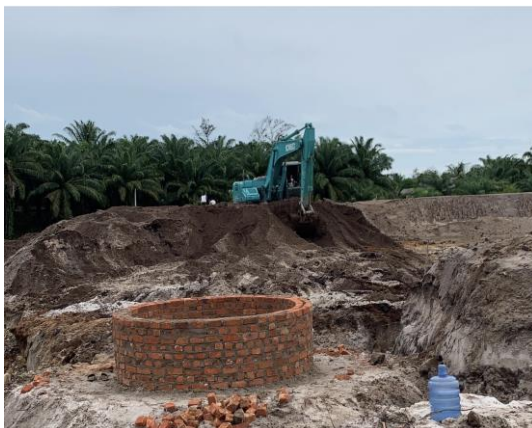
Konstruksi Saluran Pembuangan
