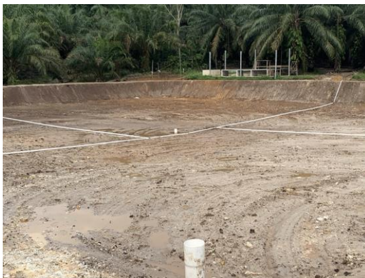
Pemasangan instalasi pipa dalam tambak
