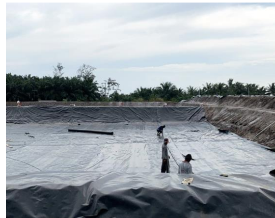
Pemasangan pelapis HDPE pada kolam budidaya
